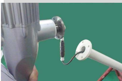
Schiebe das Kabel durch den Mast
