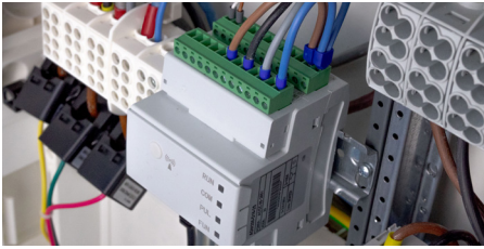
Abb. 42 ADW200 montiert auf Hutschiene (DIN 35 mm)
