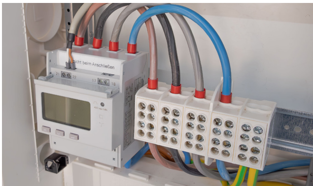
Abb. 36 ADL400 korrekt angeschlossen
